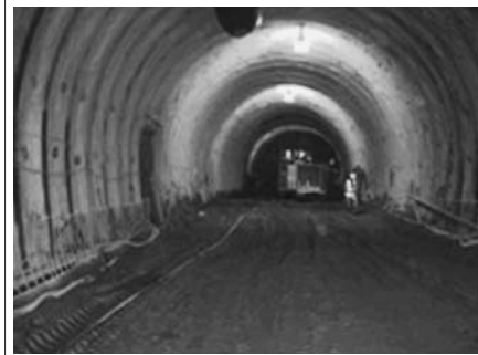
三刀屋トンネル施工状況
