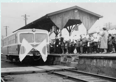
昭和34年頃木次駅構内
