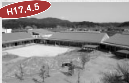
幼保一体化施設加茂幼稚園竣工
