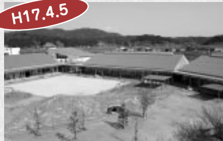
幼保一体化施設加茂幼稚園竣工
